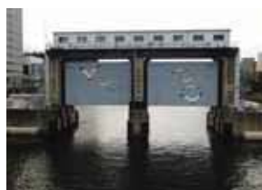
写真-1 天王洲水門
