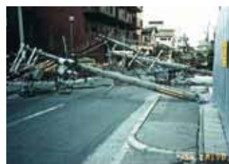
写真-1 現地状況*3
