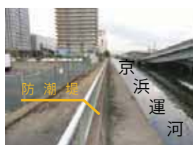
写真-3 防潮堤（八潮橋付近）
