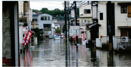
豊橋市内浸水状況（柳生川流域） / 平成20年8月末豪雨
