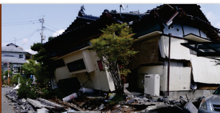
地震による揺れで倒壊した建物 / 平成28年熊本地震
